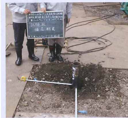
打設完了 ( 偏芯確認 )
