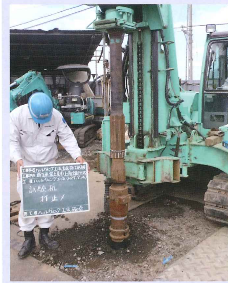
打設完了 ( 打ち止め )
