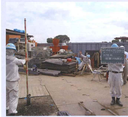
打設完了 ( レベル確認 )
