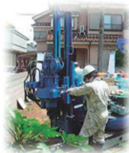
エコプロフによる掘削
